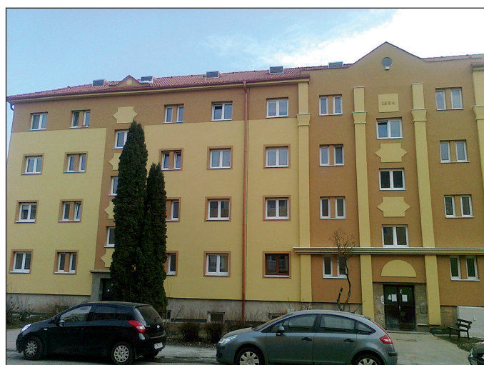
Obr. 2 Pohľad na bytový dom s tepelnými čerpadlami v podkrovi – viditeľné nasávacie a výfukové otvory na šikmej streche
