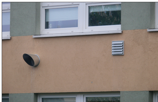
Obr. 6 Realizace nuceného větrání – sání a výfuk vzduchu na fasádě
