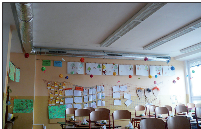
Obr. 4 Realizace nuceného větrání – přívod vzduchu
