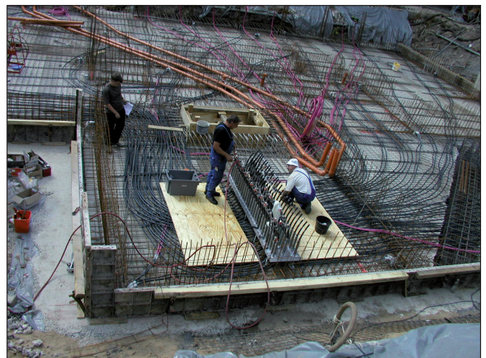
Obr. 3 Připojení pilotů na rozdělovač/sběrač
