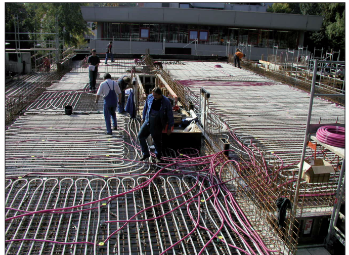
Obr. 4 Pokládka potrubí aktivní betonové konstrukce
