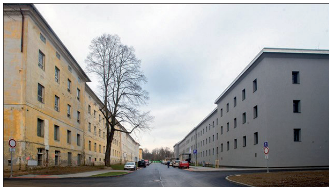
Obr. 1 Řešená budova v rámci technologického parku (vlevo)
