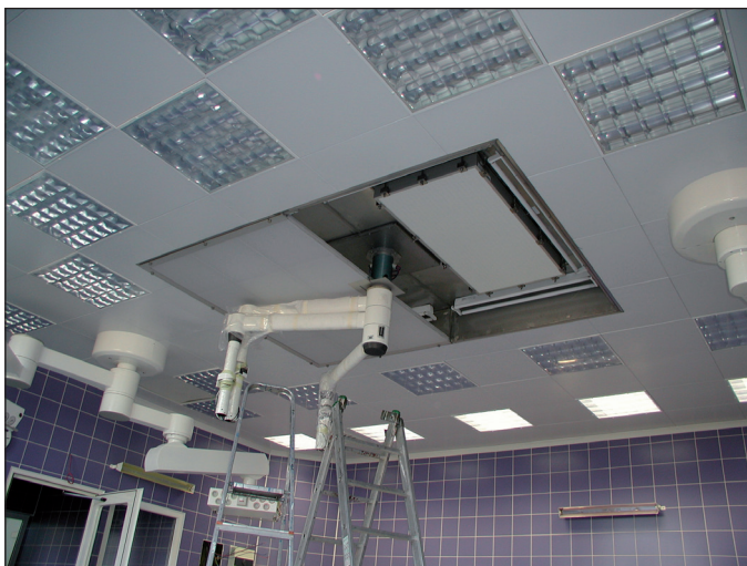
Obr. 6b Výměna filtrů HEPA v přívodním s laminarizátorem tlakovém stropu
