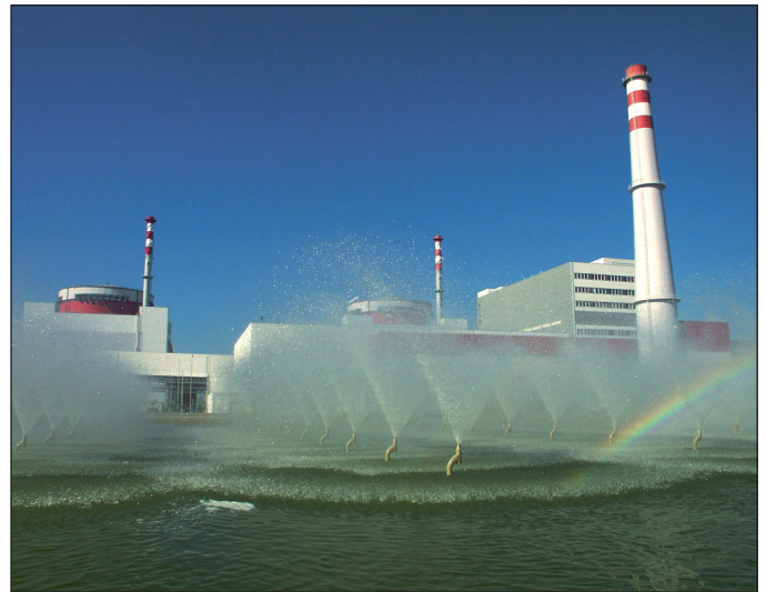
Obr. 3 Jeden z možných způsobů chlazení technické vody důležité (TVD) rozstříkem
