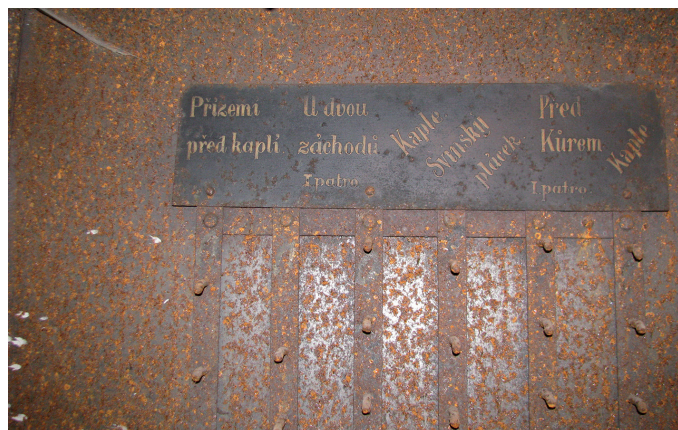
Obr. 5 Ovládání regulačních klapek pro jednotlivé vytápěné místnosti z prostoru pro obsluhu – ocelová lanka již zcela chybějí (zámek Hluboká nad Vltavou)
