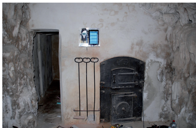
Obr. 9 Zámek Lednice – příkladací dvířka do kaloriferu pro Rytířský sál a Sál předků včetně měření teplot v jednotlivých prostorách
