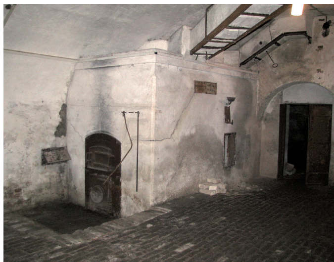
Obr. 4 Prostor pro obsluhu teplovzdušného vytápěcího systému s kaloriferem (zámek Lednice): otopná komora je opatřena revizními dvířky a vodoznakem pro kontrolu hladiny vody v odpařovací nádobě pro zvlhčování vzduchu, v přední části komory je obsluha topeniště, z kaloriferu vedou 2 kanály pro rozvod teplého vzduchu
