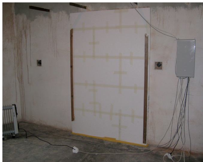
Obr. 3 Experimentální místnost č. 118 vybavená olejovými přímotopnými tělesy a systémem MaR, oddělená polystyrenovou deskou od okolních místností [zdroj: autoři]
