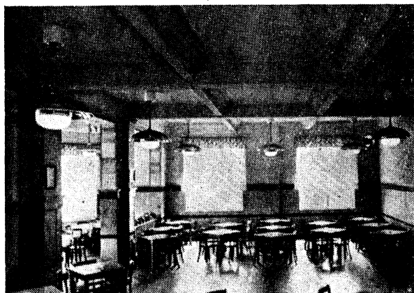
Obr. 2. Elektrický zářič kombinovaný se svítidlem.
