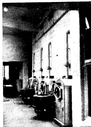
Obr. 2. Strojní vybavení prádelny se samoobsluhou.
