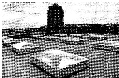
Obr. 34. Čtyřhranné průsvitné větrací hlavice (Greenwood Ltd.).
