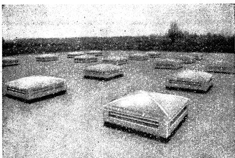
Obr. 36. Čtyřhranné průsvitné větrací hlavice (Greenwood Ltd.).
