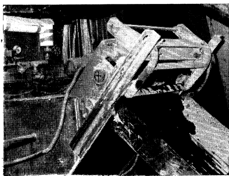
Obr. 8. Otočný skluz pod vyhrabovačem kalu.
