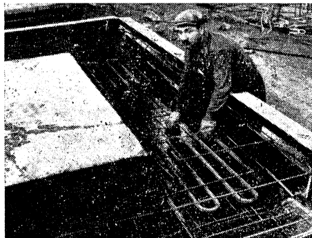
Obr. 3. Ukládání ocelového, trubkového vytápěcího elementu do venkovního stěnového panelu v době před zalitím (1 — trubkový vytápěcí element, 2 — okraj formy panelu, 3 — jádro formy sloužící k vytvoření otvoru pro okno).
