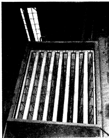
Obr. 3. Pohled na kapsovou vložku filtru FKA po otevření víka komory.
