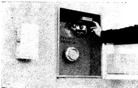
Obr. 8. KOVO Praha; vyústění suchovodu s tlačítkem čerpadel.
