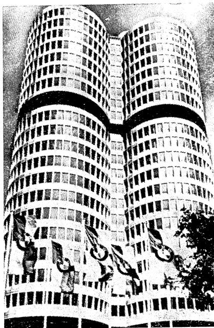
Obr. 6. Ukážka zámerného využívania šikmého zasklenia so sklonom  $100^\circ$  v ľahkom obvodovom plášti klimatizovanej administratívnej budovy BMW v Mníchove.
