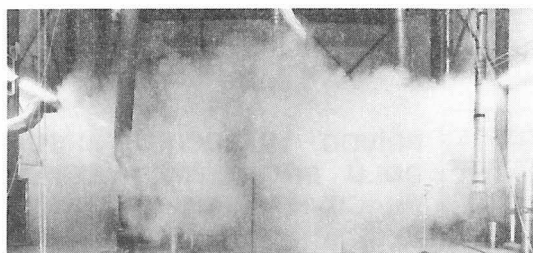
Obr. 13a, b, c Vyústka typu TLB při chlazení (montáž dvojice kolem sloupu na stěně)
