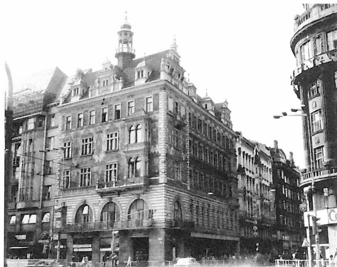
Obr. 1 Obytný dům v Praze 1, nároží Václavského nám. a Vodičkovy ulice (autor A. Wiehl, rok výstavby 1894)
