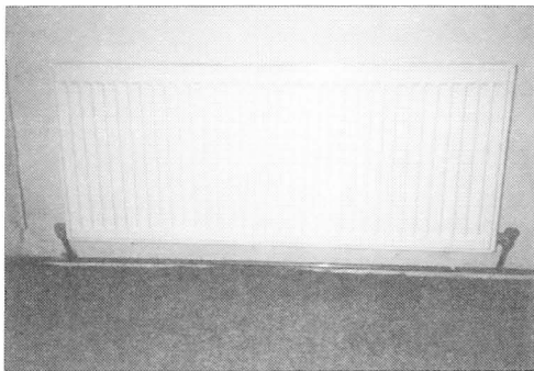
Obr. 5 Zapojení otopných těles "jezdeckým" způsobem
