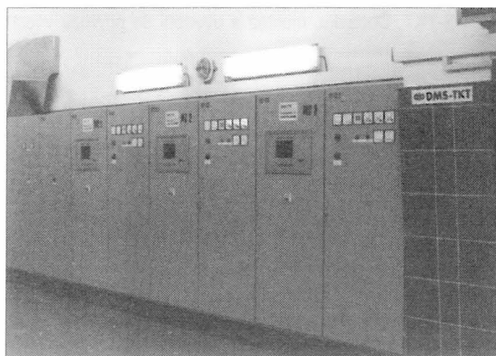
Obr. 4 Ovládací skříň TEM a ZAS firmy MWM Deutz
