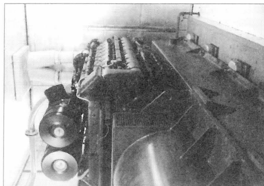
Obr. 3 Plynový motor MWM Deutz uvnitř protihlukového krytu
