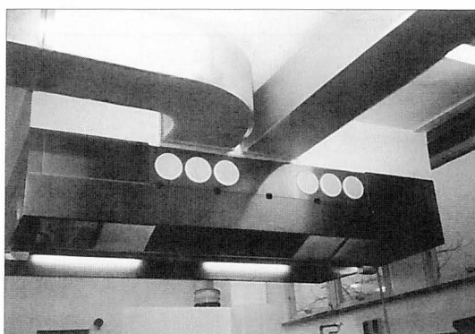
Obr. 3 Realizace DINER digestoře ve velkokuchyni
