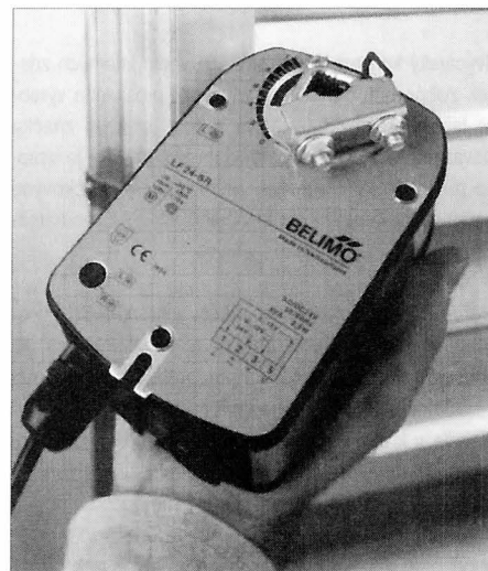
Obr. 2 Servopohon s havarijní funkcí (zpětná pružina) řady LF...
