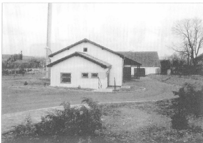
Obr. 1 Celkový pohled na stavbu výtopny s příjezdovými vraty pro zavážení balíků paliva
