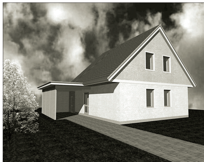
Obr. 9 Severozápadní (uliční) průčelí pasivního domu
