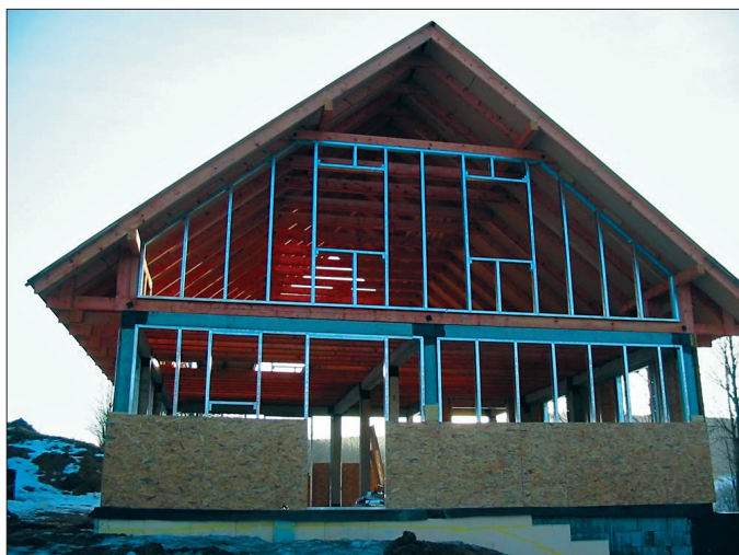
Obr. 4 Příklad skeletové konstrukční soustavy pasivního domu
