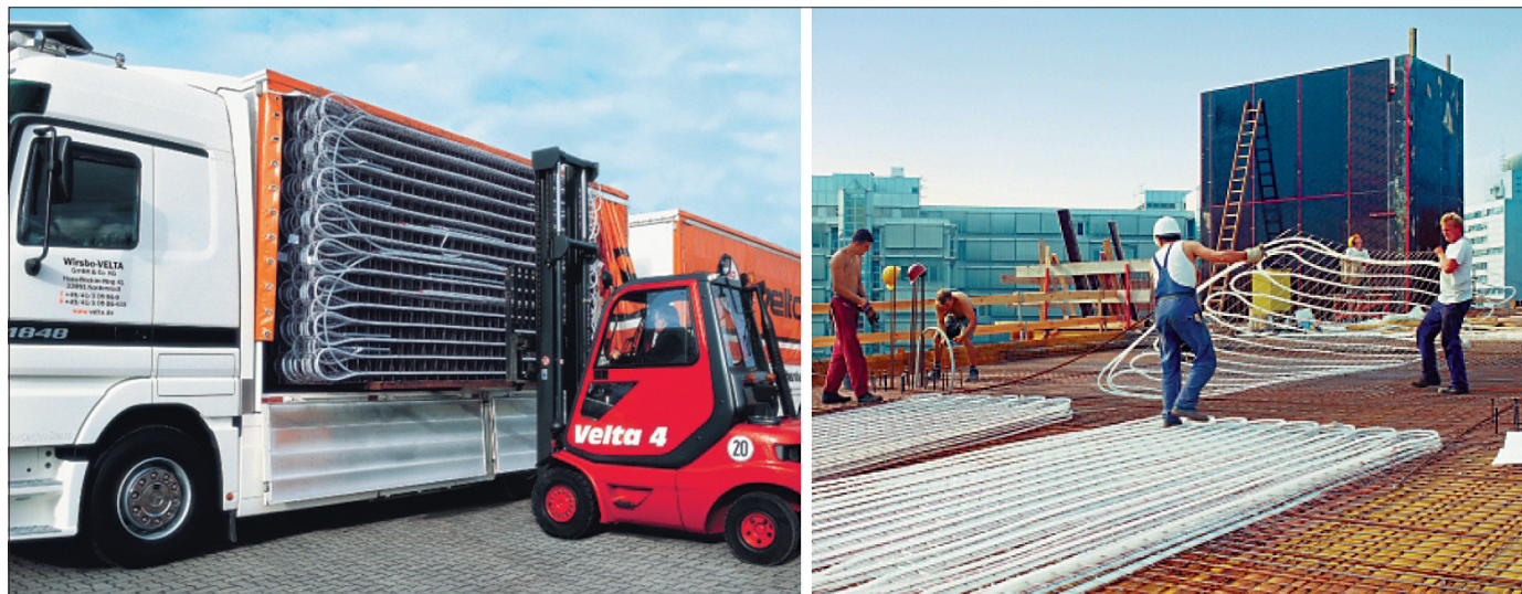
Obr. 3 Prefabrikovaný modul trubkového registru (obrázky z materiálů firmy Velta) a) transport trubkového registru na stavbu, b) pokládka registru na výztuž nosné betonové desky
