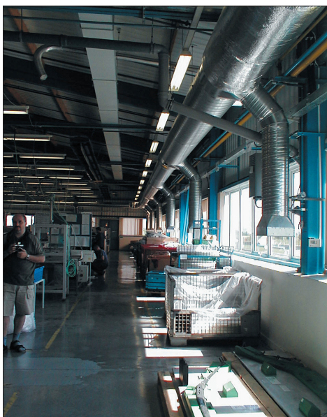
Obr. 2 Přívod u východní stěny
