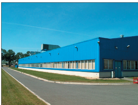
Obr. 1 Hala s klimatizační jednotkou na střeše
