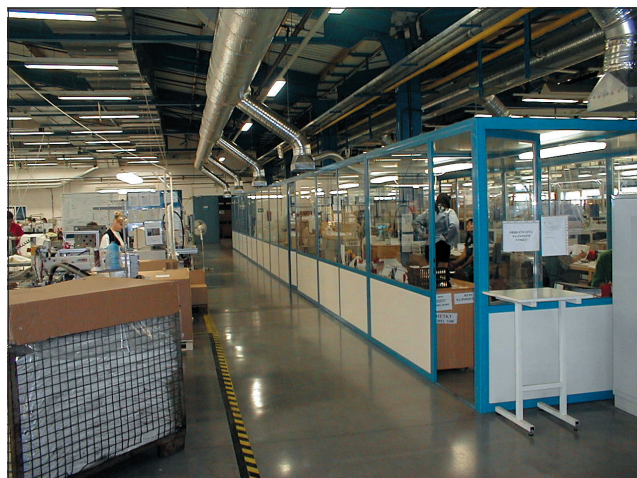
Obr. 4 Přívod u části západní stěny s vestavěnými kanceláři
