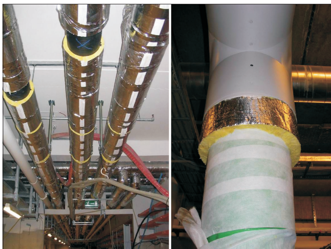
Obr. 4 Příklad použití izolace HygroWick na chladicích rozvodech
