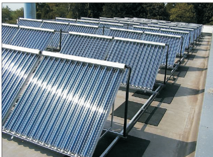
Obr. 3 Pole trubkových solárních kolektorů na střeše administrativní budovy a venkovní adsorpční chladicí jednotka v areálu firmy Instaplast, a. s.
