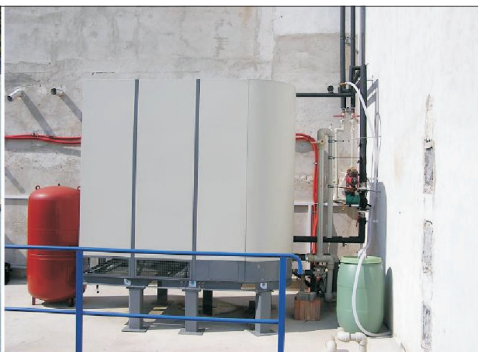
Obr. 3 Pole trubkových solárních kolektorů na střeše administrativní budovy a venkovní adsorpční chladicí jednotka v areálu firmy Instaplast, a. s.
