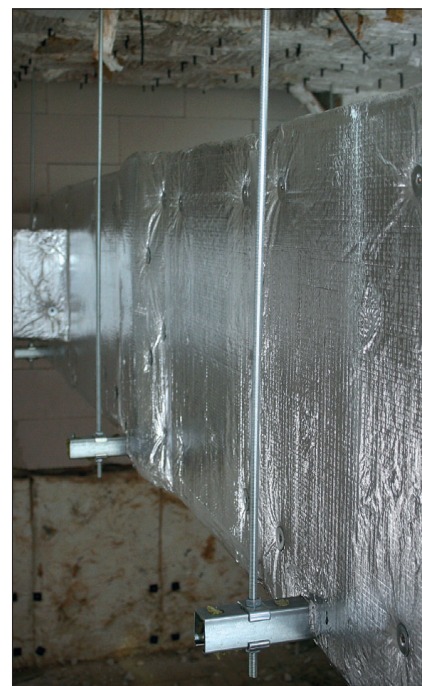
Obr. 9 Zavěšení potrubí závitovými tyčemi a nosnými lištami.
