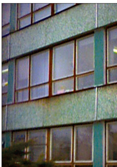
Obr. 8 Pohľad na fasádu [6]
