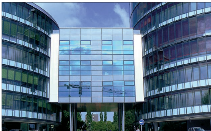
Obr. 2 Pohľad na objekt [4]
