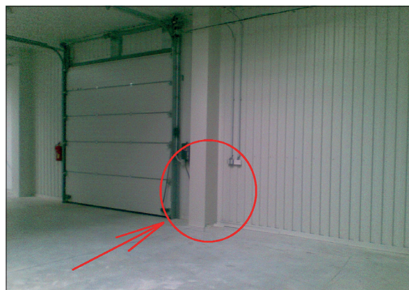
Obr. 10 Interiér haly – fotografie – vjezdová vrata, konstrukce haly
