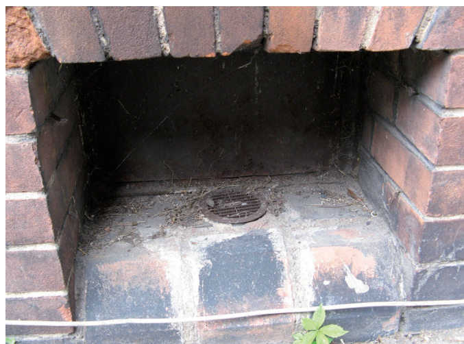
Obr. 7 Výdechový otvor v parapetu okna
