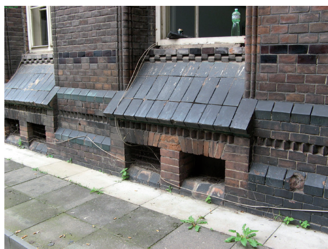
Obr. 2 Pohled na severní fasádu křídla G4 se vzduchovým kanálem a sklepním okénkem Fig. 2 View of the northern facade of the wing G4 with air flue and cellar window
