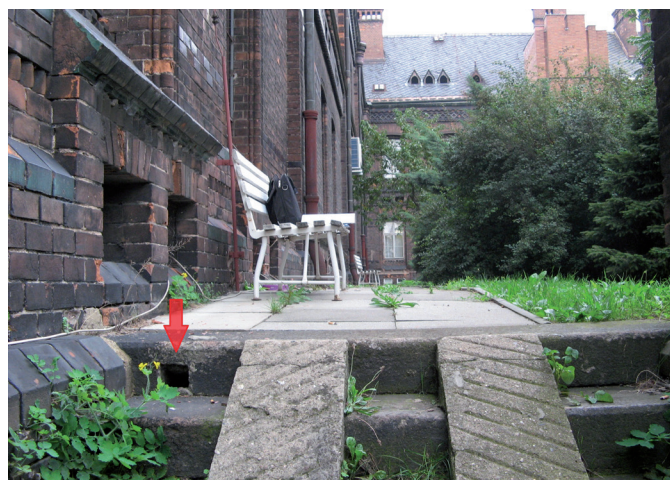
Obr. 5 Schodiště s nasávacím otvorem „N1“
