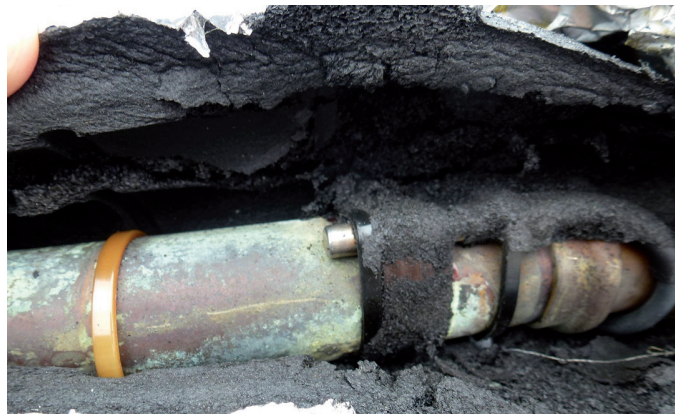
Obr. 4 Příložné umístění kolektorového čidla
