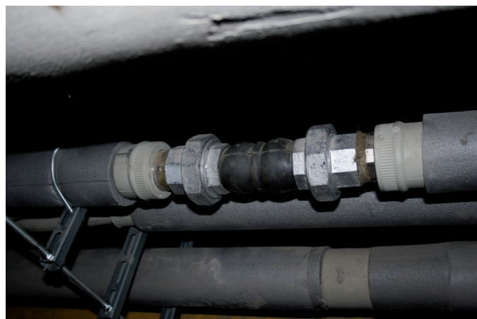
Obr. 4 Osový kompenzátor napojený pomocí tvarovek z temperované litiny
