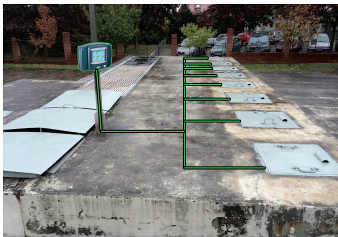
Obr. 4 Napojení kontroléru na vymírací nádrže
