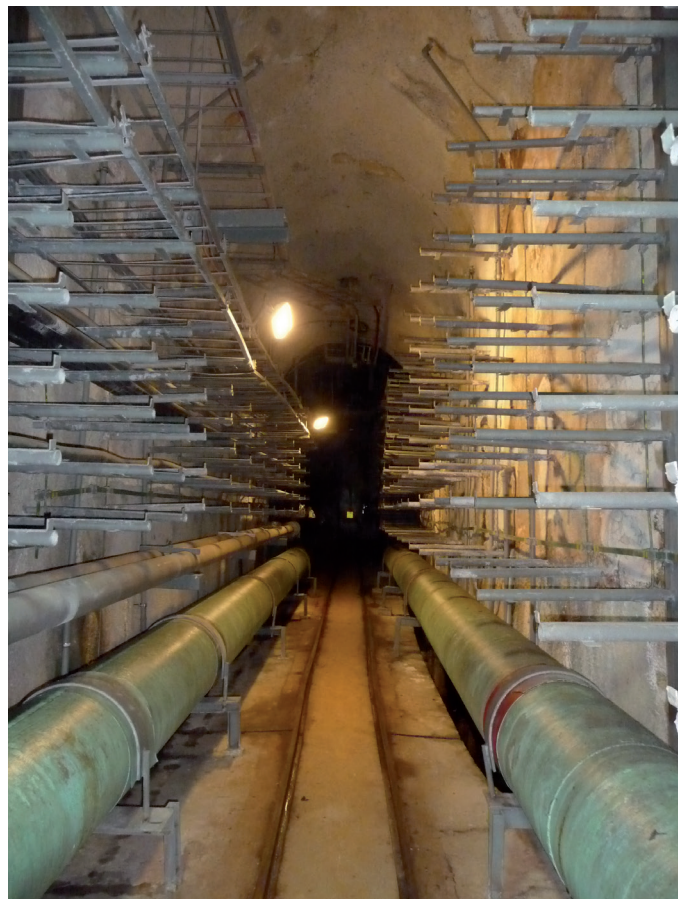
Obr. 6 Pohled do kolektoru
