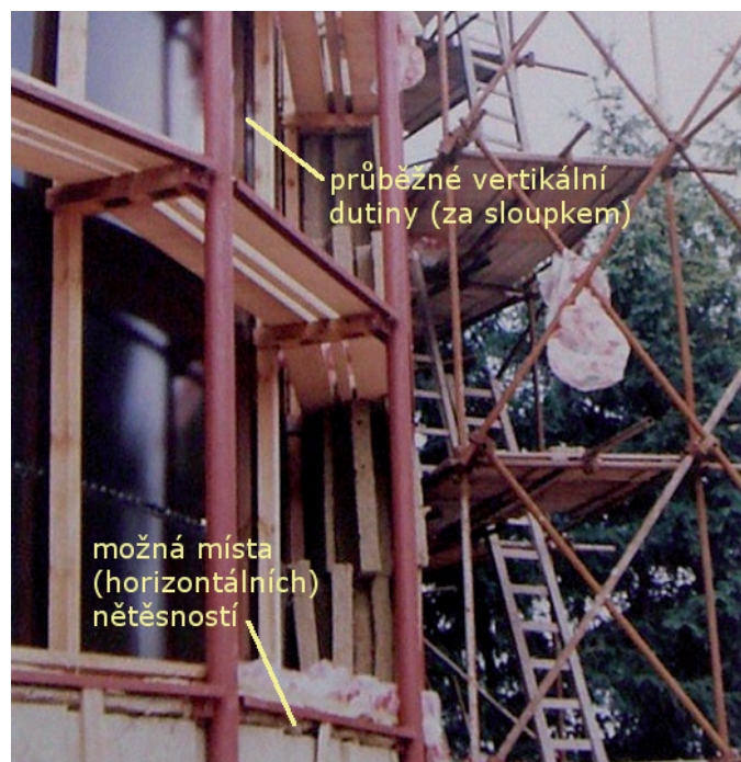
Obr. 1 Plášť zásobníku v době výstavby
