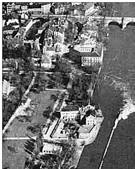
Obr. 1 Pohled na Sovovy mlýny před rekonstrukcí
