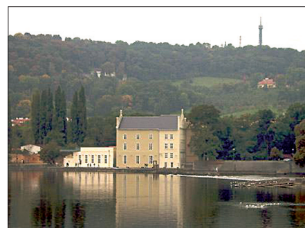
Obr. 11 Sovovy mlýny po rekonstrukci
