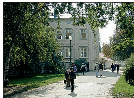
Obr. 10 Budova s galerií po rekonstrukci
