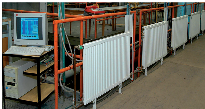
Obr. 1 Měření vlastností jednotrubkové otopné soustavy
