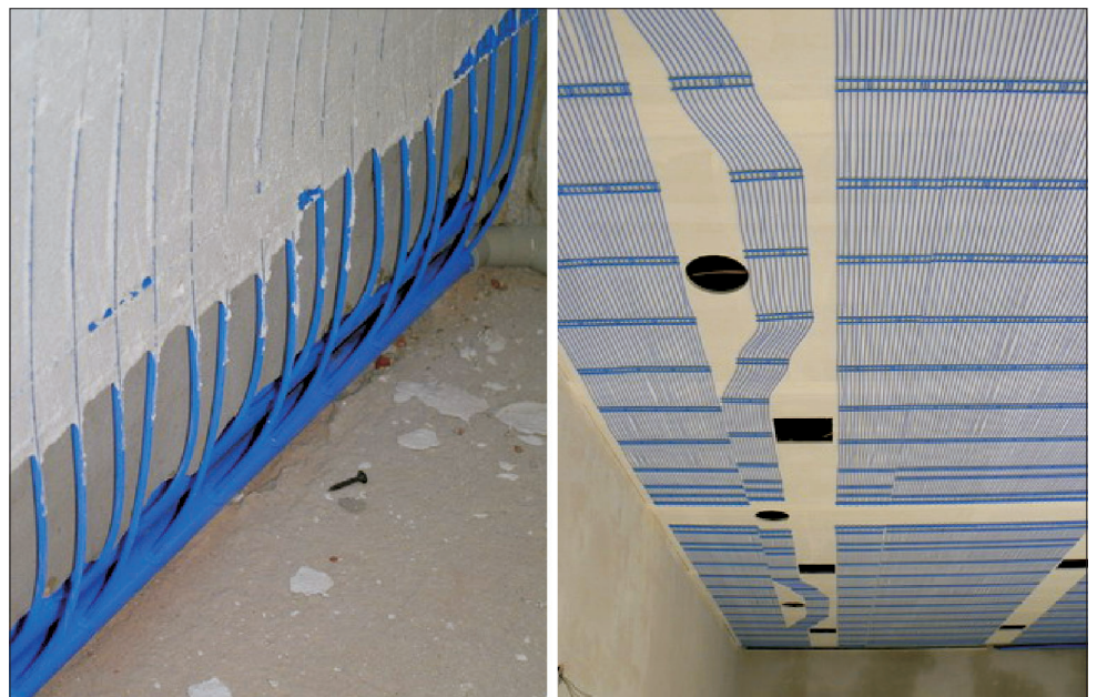
Obr. 3 Kapilární rohože na stěně a na sádkartonu připravené k omítnut
