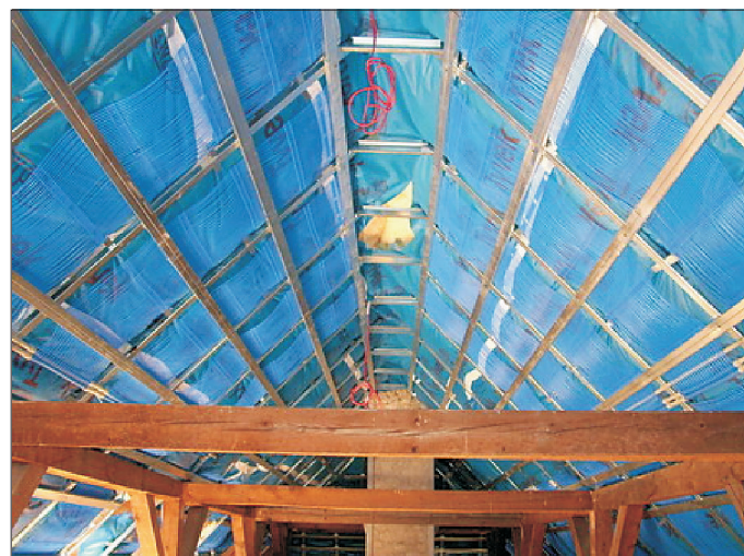
Obr. 10 Instalace kapilárních rohoží v podkroví historické budovy
