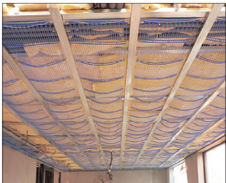
Obr. 6 Kapilární rohože zavěšené na rastr pro sádrokarton
