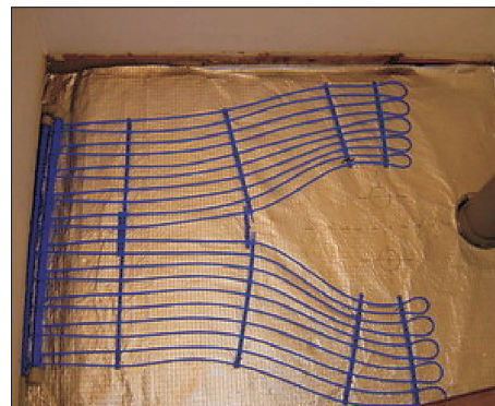
Obr. 8 Aplikace kapilárních rohoží do podlahy
