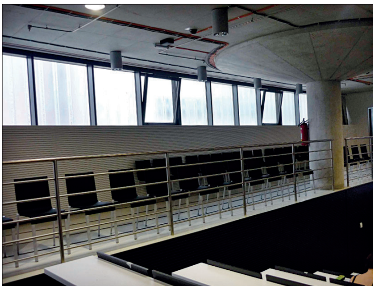
Obr. 6 Automaticky otevíraná okna v konferenčním sále
