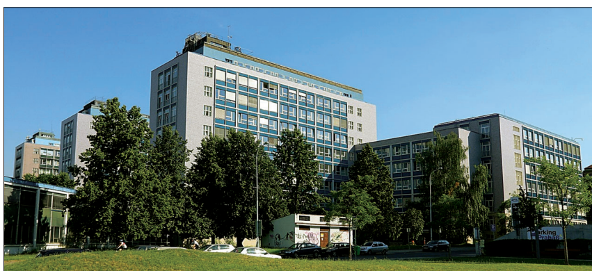
Obr. 1 Budova ČVUT v Praze
