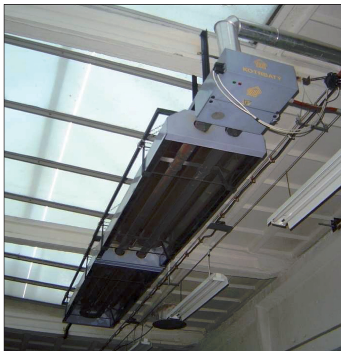
Obr. 3 Plynový tmavý zářič KM-U 10 v halových laboratořích
