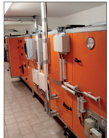
Obr. 8 Připojení VZT jednotky bez expanzních ventilů – dvouokruhový výměník, jednoduchá montáž
