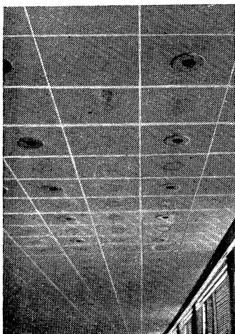
Obr. 2. Zaprášení sádkového podhledu pod vyústkou.
