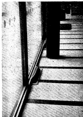
Obr. 3. Ofukování oken vyústkou v podlaze (Stadthalle).
