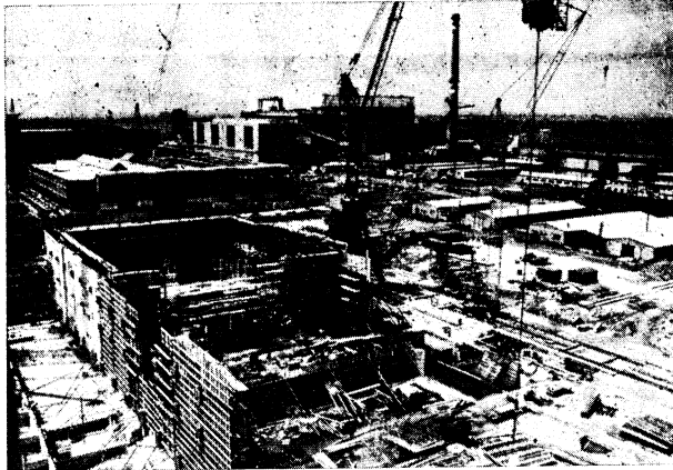
Obr. 1. Výstavba budovy reaktorů JE V1 Bohunice. V pozadí první československá jaderná elektrárna A1, která je v provozu od r. 1972.
