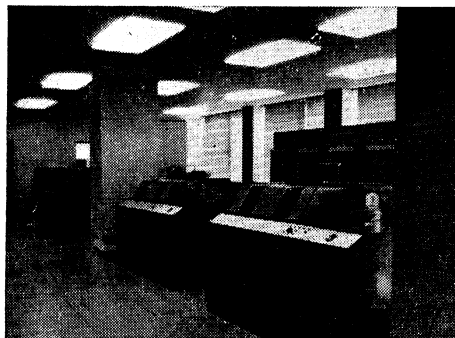
Obr. 2. Pohled na obložení příčných stěn a sloupů v sále počítače LEO 360
